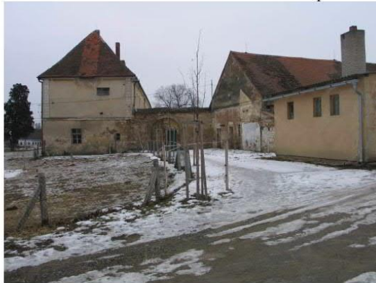
Foto 3: Pohled na budovu zámku a severní část přestavbové plochy SVa 1.
