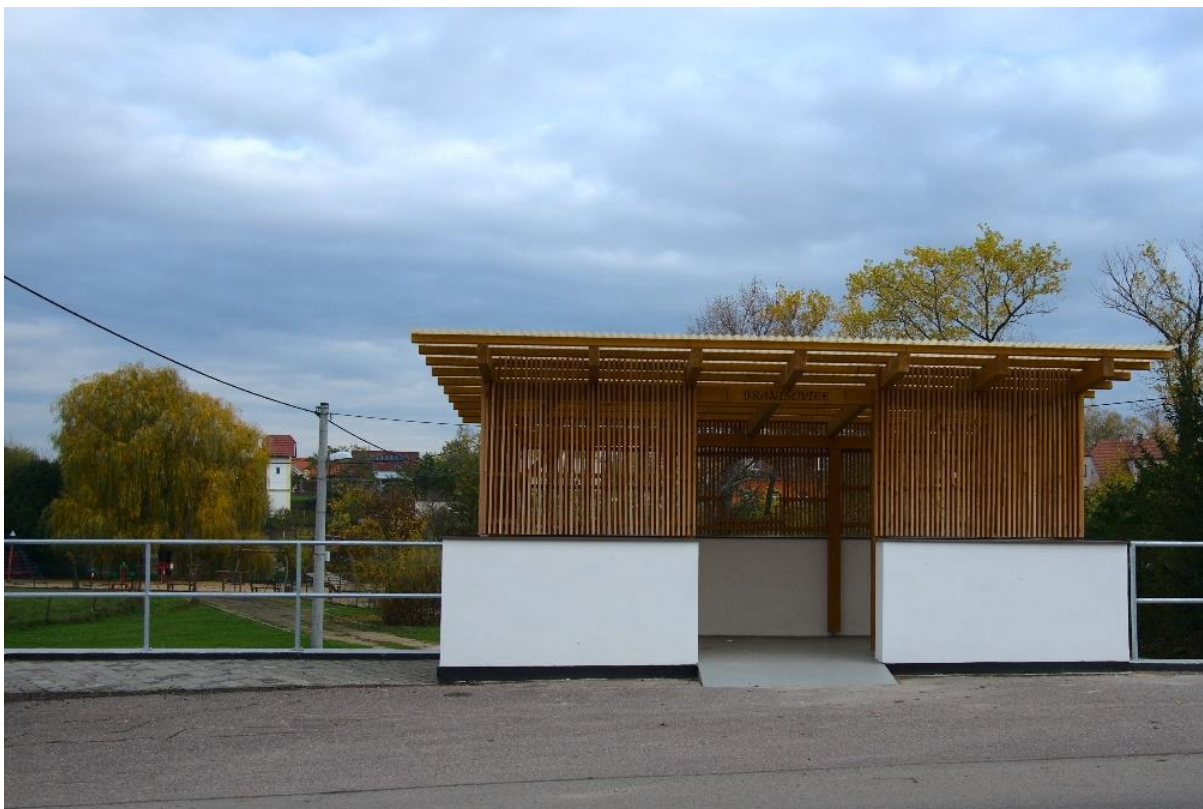
Obr. 17 Zrekonstruovaná autobusová zastávka Branišovice, pošta v roce 2020
